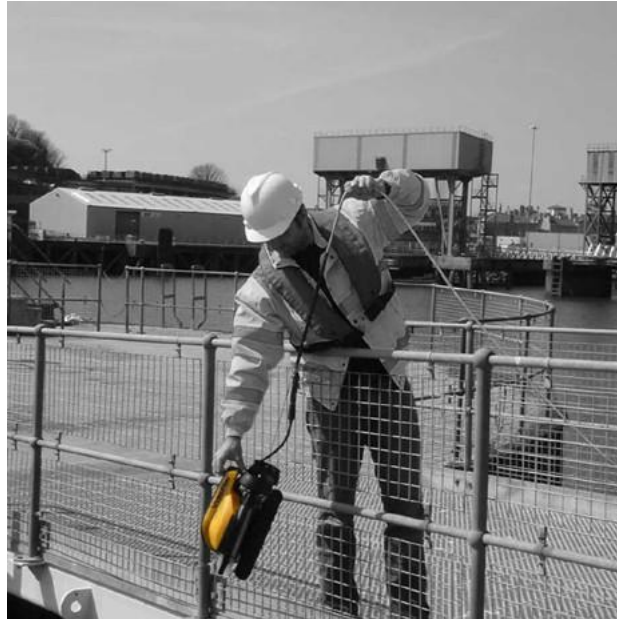
Khảo sát, xây dựng cơ sở hạ tầng
